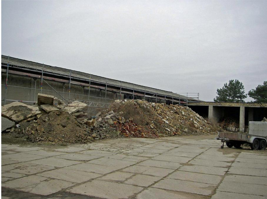
**Abb. 13:** Beispiel für abgelagerten Bauschutt, der durch Recycling der Wiederverwertung zugeführt werden soll, hier Nordecke vor der Mehrzweckhalle.
