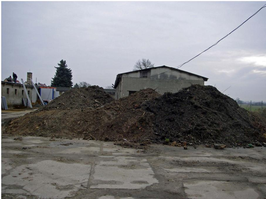
**Abb. 12:** Beispiel für abgelagerte Erdstoffe, hier am Nordgiebel der Lagerhalle (Baufeld 3). Die Erdstoffe sind Aushubmaterialien, die wieder verwendet werden.
